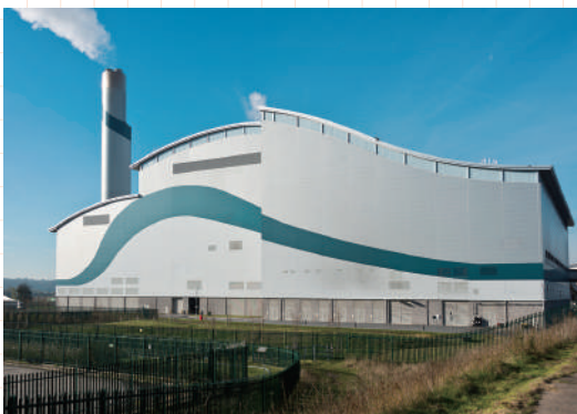
ごみ焼却施設
